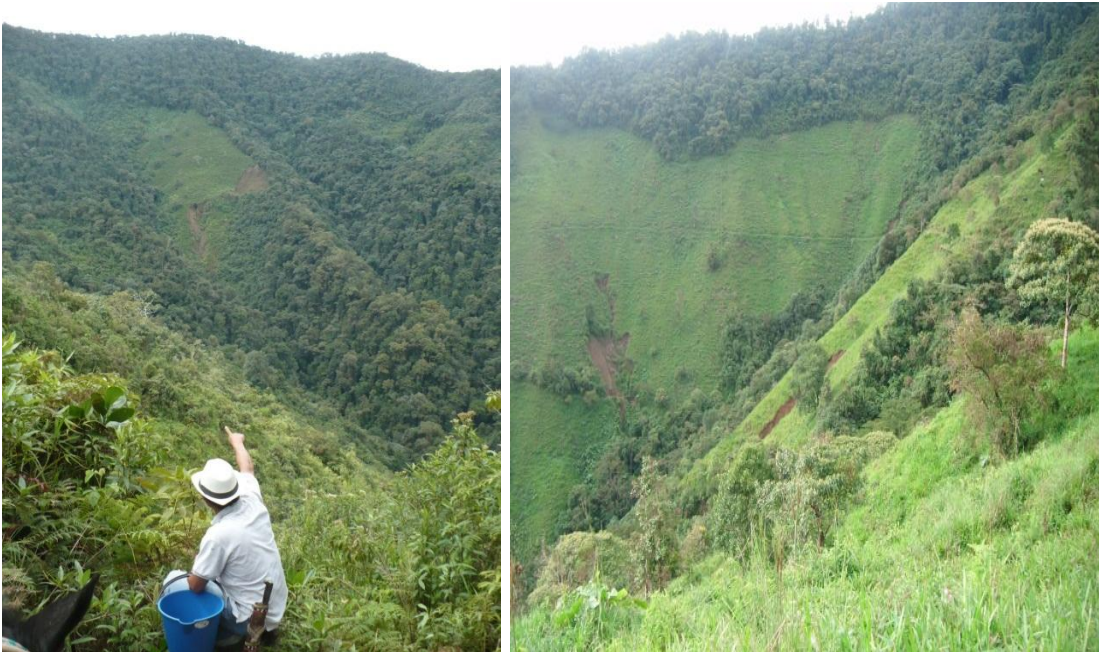
Foto 2. a) Morfología y vista general de las cuencas abastecedoras del acueducto, b) Línea de conducción en la vertiente, con movimientos en masa por debajo de ella.
