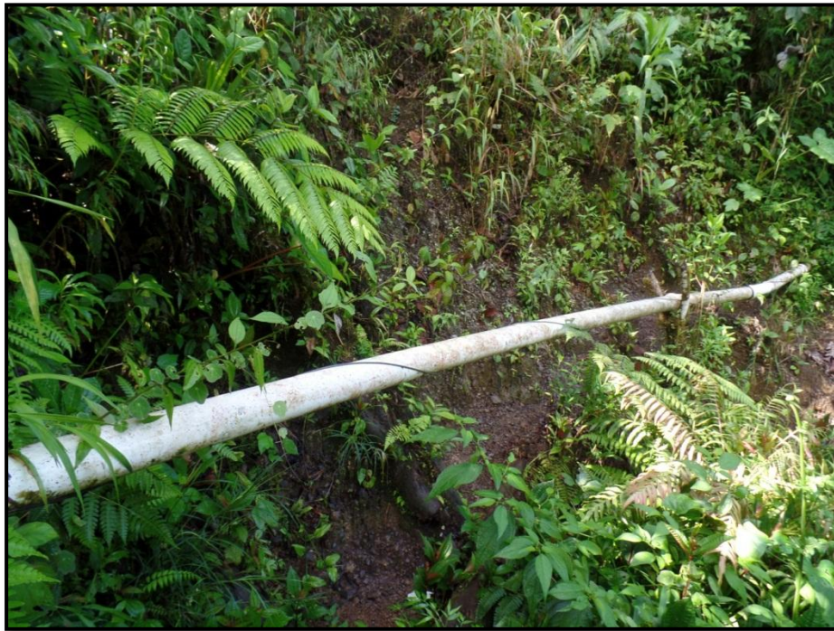
Foto 6. Afloramiento rocoso, La tubería no presenta empotramiento
