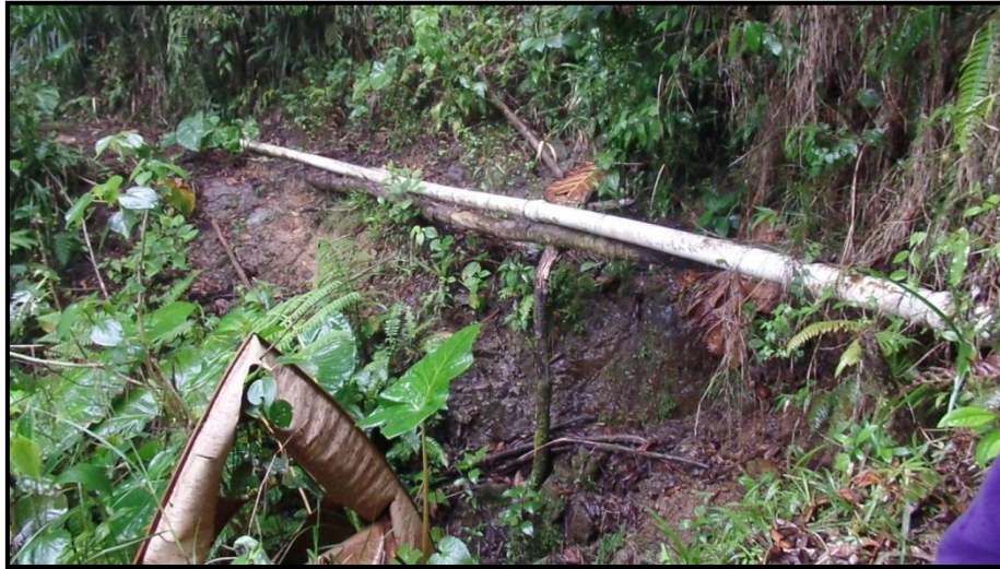
Foto 4. Afloramiento rocoso, tubería con falta de empotramiento
