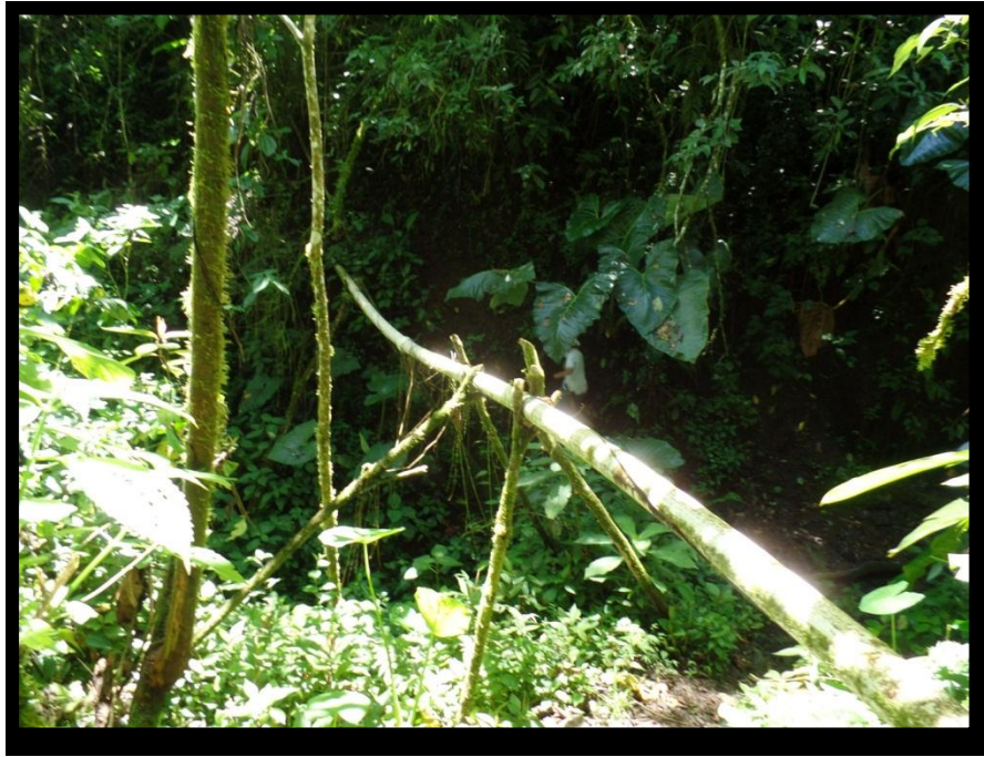
Foto 12, 13 y 14. Tramo de Tubería deflectada por falta de apoyo y pérdida de lineamiento horizontal y vertical
