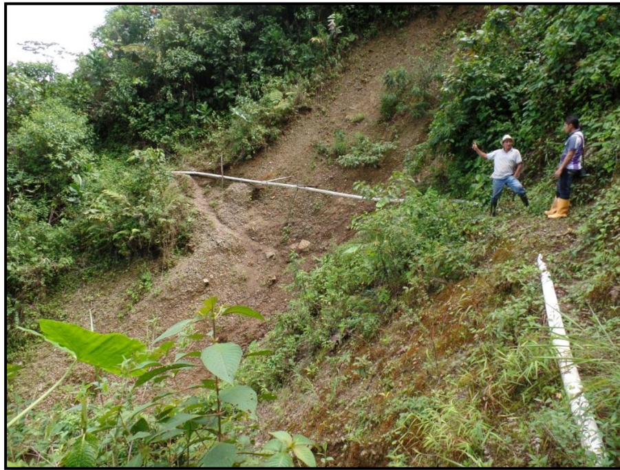
Foto 8. Tramo de Tubería Afectada por Deslizamiento y perdida de lineamiento horizontal
