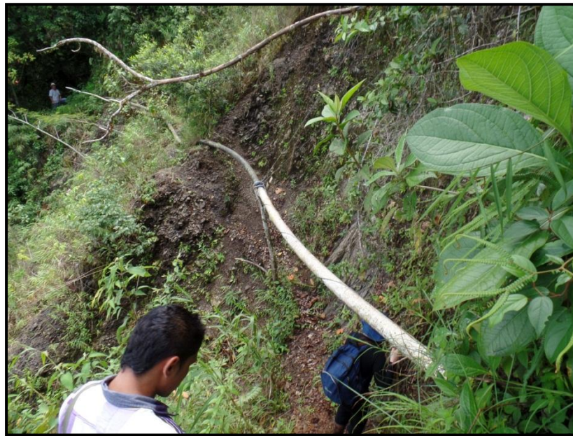
Foto 10 y 11. Tramo de Tubería deflectada por falta de apoyo y pérdida de lineamiento horizontal
