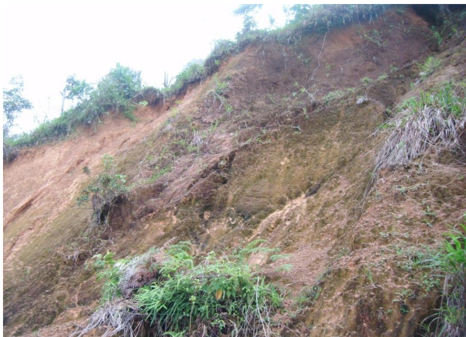
Foto 3. Movimiento en masa mayor de la conducción, se observa crecimiento de líquenes en algunas partes, indicio de estabilización.
